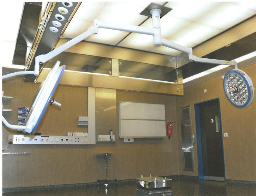
Lüftungs- und Filtersysteme in der Decke erzeugen einen laminaren, sterilen Luftstrom im OP-Feld.
